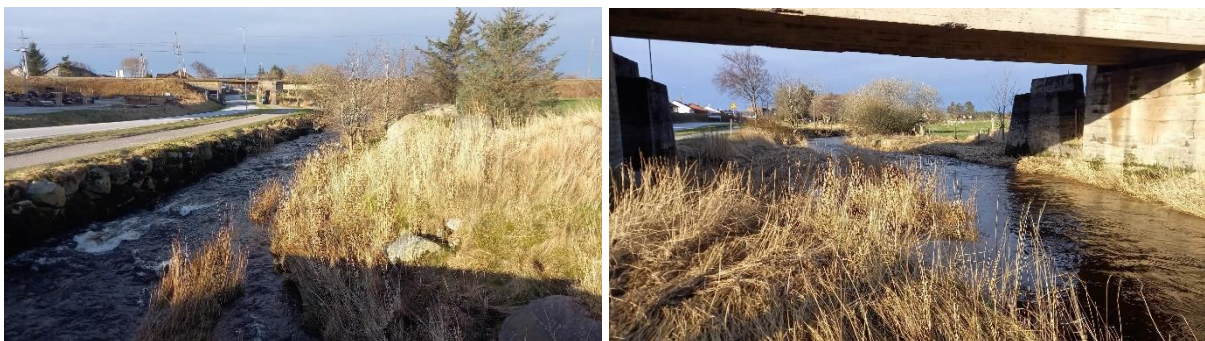
Figur 2-21. Delstrekning 5. Opsjon (vil utføres dersom prosjektets økonomi tillater det): Å fjerne grantrærne og skrelle av grov stein i kanten på nordsiden (bilde t.v.), samt å fjerne vegetasjonsbanker og finstoff i elvekant oppstrøms og nedstrøms jernbanebroa (bilde t.h.).
