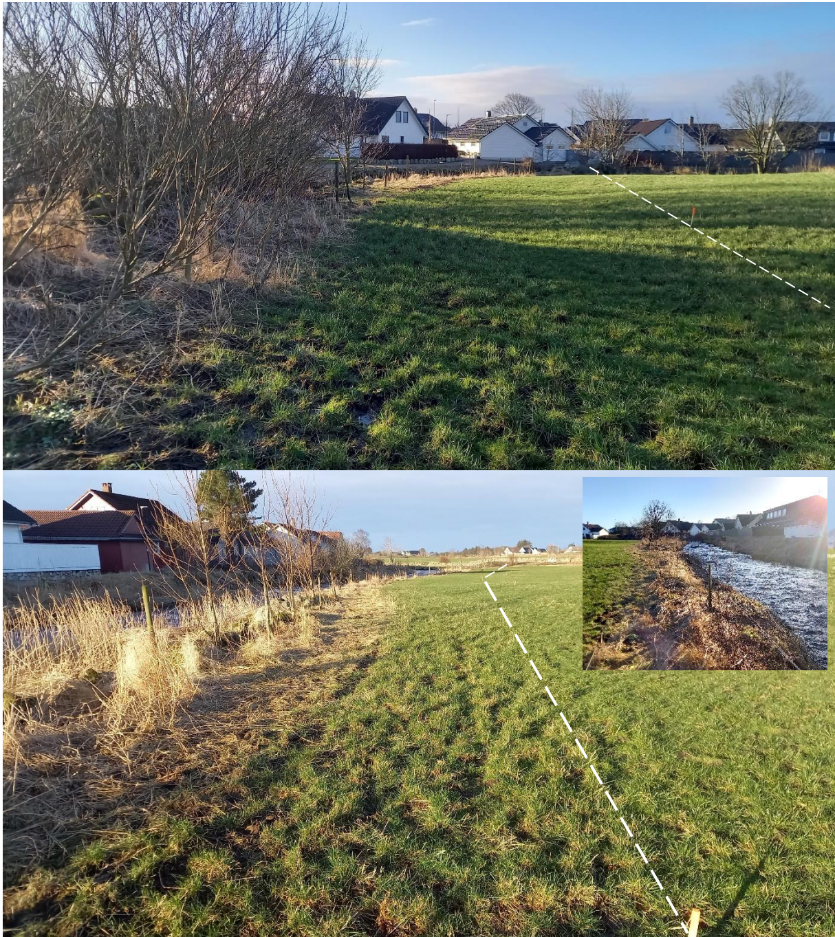
Figur 2-15. Delstrekning 3. Elvekantene skal skrås inn til stiplet linje på nordsiden av løpet, et 300 m langt strekk. Mindre løvtrær i kantsonen må fjernes.
