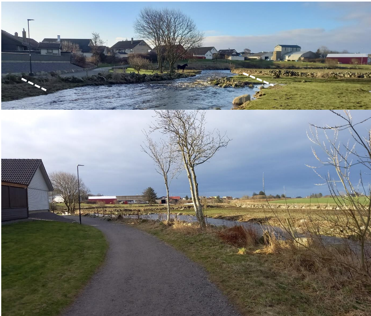
Figur 2-16. Delstrekning 4. Et mindre felt på nordsiden skal graves ut (omtrent til stiplet linje), og elvekantene på sørsiden (stiplet linje) skal skrås inn mot gangstien på sørsiden (nedre bilde).
