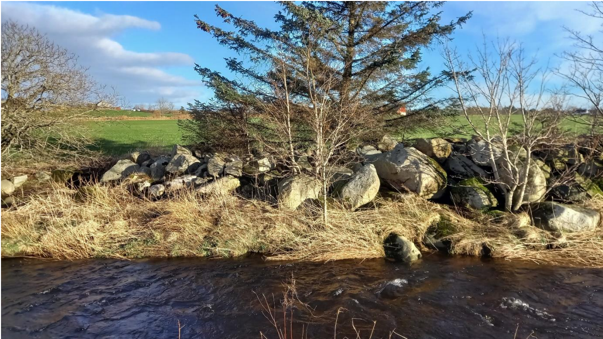
Figur 2-22. Fjerning av sitkagrana og øvre steinlag i elvekanten på nordsida av delstrekning 5 er lagt inn som opsjon.
