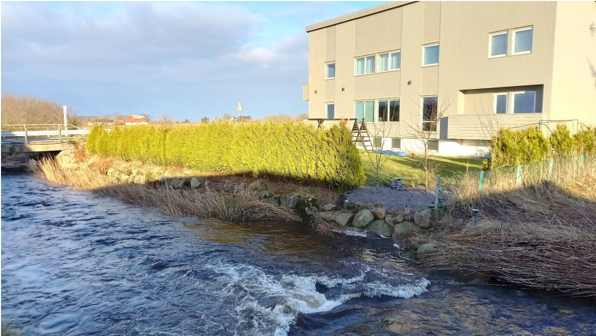
Figur 2-8. I midtre del av delstrekning 2 er elvekantene utbygde helt inn til løpet av både tursti på sørsiden og hage på nordsiden, og det er derfor lite rom for naturbaserte løsninger. Flomsikring vil utføres ved elvebunnsenkning fra terskel og under Ånestadvegen. I tillegg vil eiendommen sikres ved flomvoll i terrenget oppstrøms samt at gjerde settes opp over den steinsatte kanten. Den steinsatte elvekanten langs turstien skrås så mye som mulig på sørsiden.
