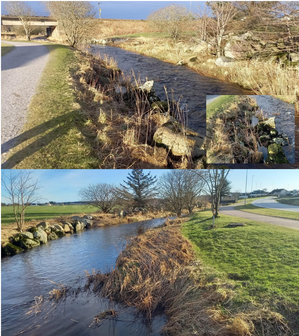
Figur 2-18. Delstrekning 5. Turstien skal heves og etableres som flomvoll mot veien. Dette innebærer fundamentering i bunn av gangstien, og at turstien i anleggsperioden blir ei langsgående gravegrop. På det 125 m lange strekket har elvekanten vegetasjonsbanker og/eller stein fra de plastrede kantene har rast ut. I forbindelse med tiltaket på gangstien er det aktuelt å vedlikeholde de steinsatte elvekantene. Det er risiko for at enkelte av løvtrærne som står tett på gangstien må fjernes eller får skade på rotnettet.
