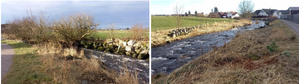
Figur 2-20. Delstrekning 3. Nedstrøms Ånestadvegen dumpes hageavfall og masser på sørsida, og elveløpet er snevret noe inn som følge av det. Aktuelle avbøtende tiltak: Å fjerne hageplanter og hageavfall i kantsonen, å plante ut norske løvtrær i kantsonen og å sette opp informasjonsskilt om vannmiljøet og fremmedarter. Opsjon (vil utføres dersom prosjektets økonomi tillater det): Å skrelle av tilført masse i kanten av sørsiden langs delstrekning 3.
