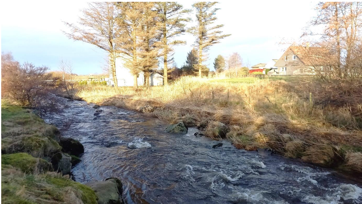
Figur 2-7. I øvre del av delstrekning 2 skal nordsiden graves ut, skrås og erosjonssikres på ny, og flomvoll skal etableres i terrenget over. Trærne på nordsiden må fjernes. På sørsiden vil den steinsatte kanten som er synlig til venstre skrås helt inn mot turstien (0,5-1 m) for å øke flomvolumet til elva.
